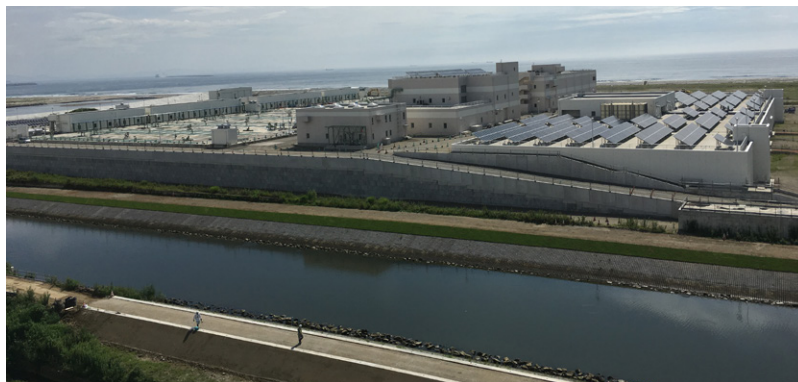
復旧後の「南蒲生浄化センター」の様子
