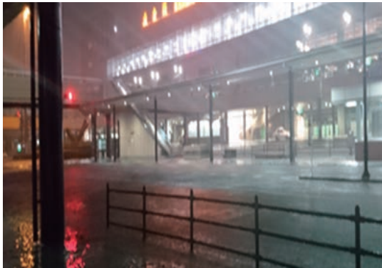
仙台駅前の冠水被害（令和元年東日本台風）
