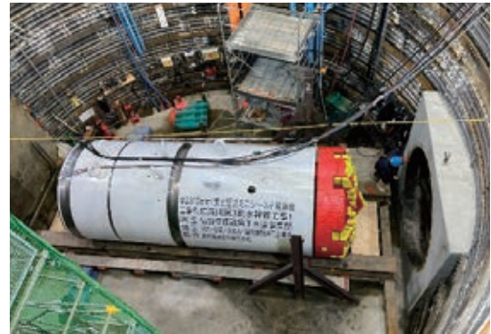
シールドマシンによる掘進工事
