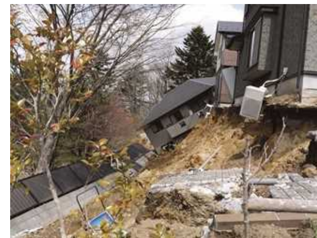
宅地被害の様子 (H23.4青葉区西花苑)
