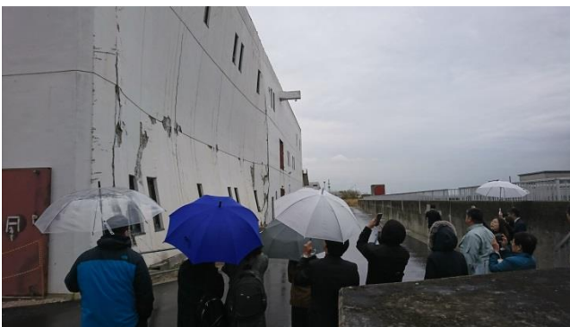
南蒲生浄化センター
